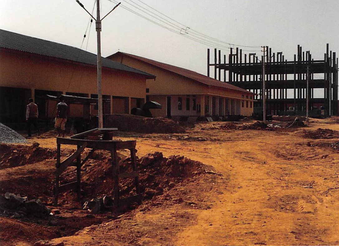
建設中の拘留所
